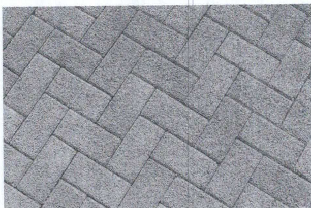
Piso intertravado de concreto cor natural
